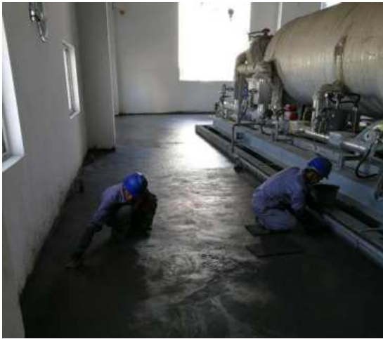
尿素车间防渗措施施工
