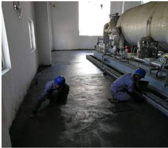
尿素车间防渗措施施工
